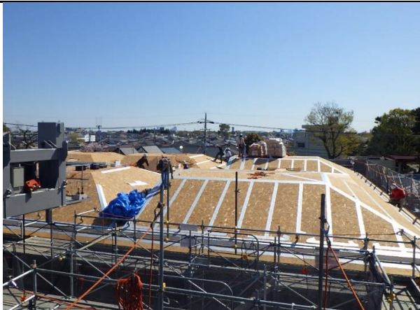
東棟屋根木下地工事施工状況
