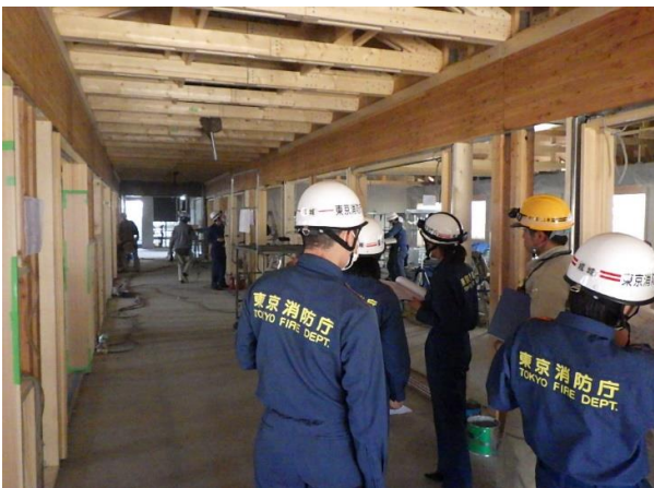
消防中間検査状況
