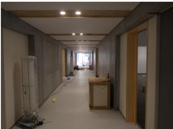
東棟1階廊下内装工事状況
