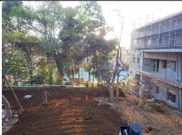
観察の森造成工事状況
