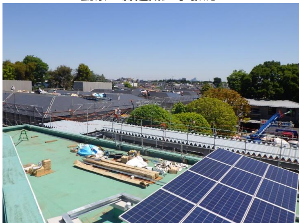
中央棟屋根工事状況
