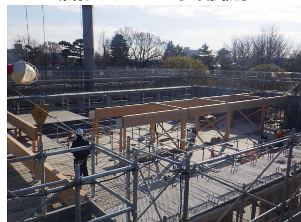
中央棟屋根木柱、梁設置状況
