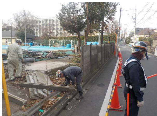
プール北側既存万年堀撤去状況
