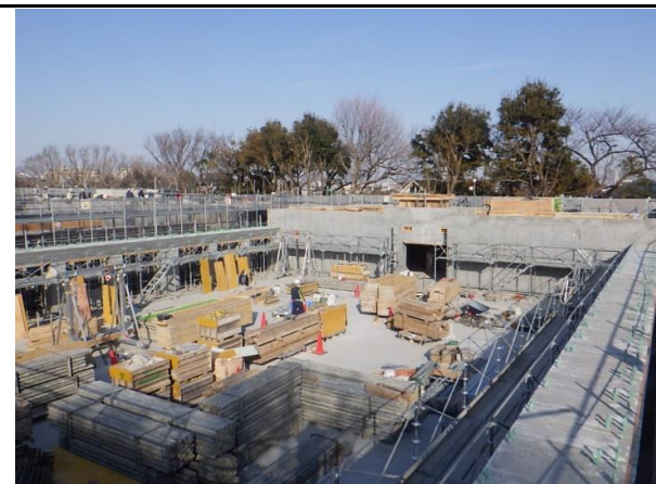
東棟2Fコンクリート出来形状
