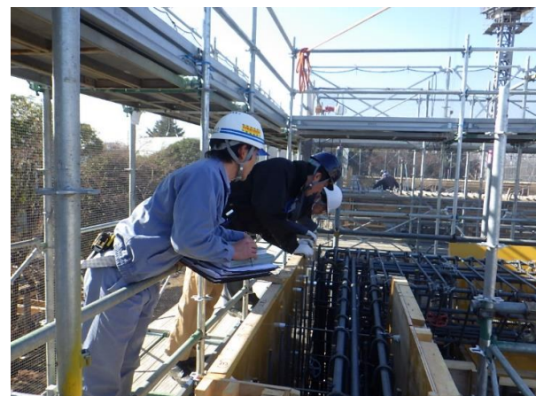
発注者、設計監理者品質検査状況
