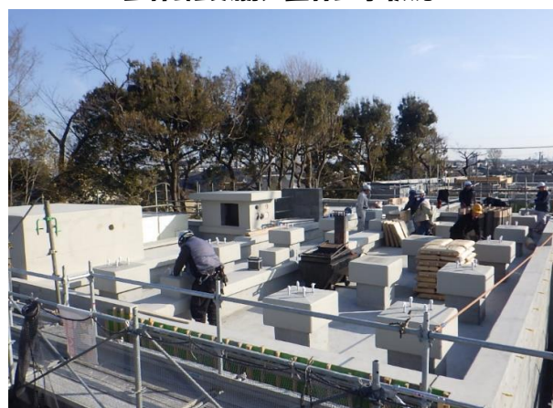
中央棟屋上防水工事状況
