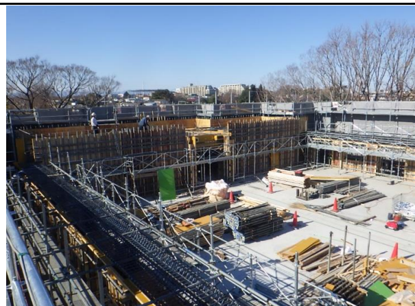
西棟2階鉄筋、型枠工事状況
