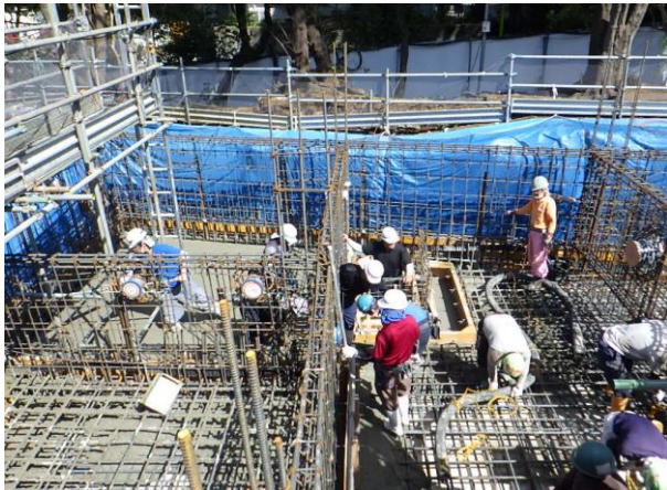
中央棟耐圧盤コンクリート打設状況
