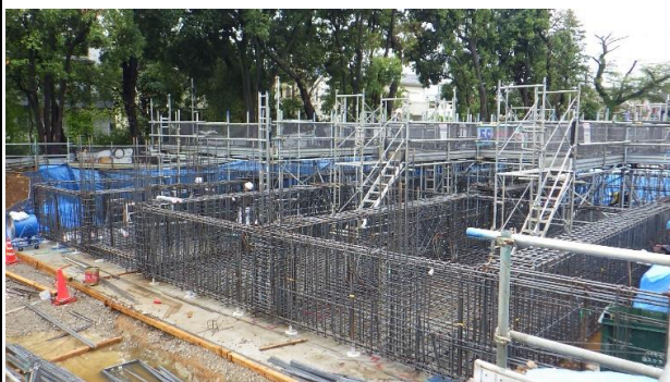
中央棟基礎配筋状況
