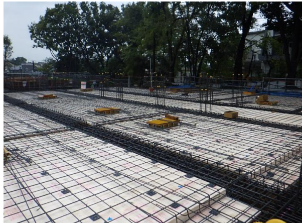
中央棟1階床配筋状況
