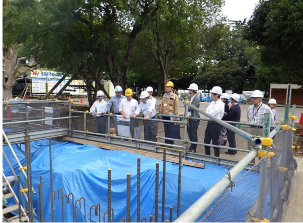
発注者、監理者現場巡視状況
