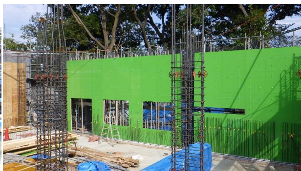
西棟地下型枠・配筋状況
