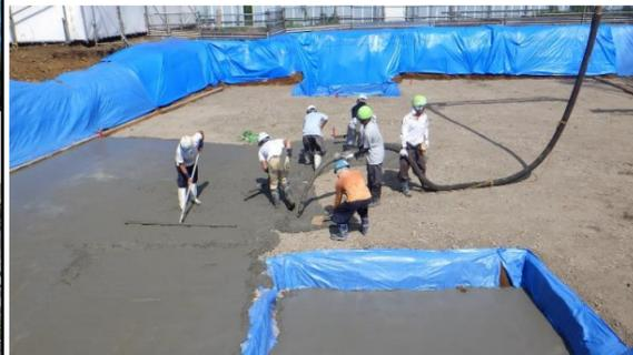
東棟基礎レベルコンクリート打設状況
