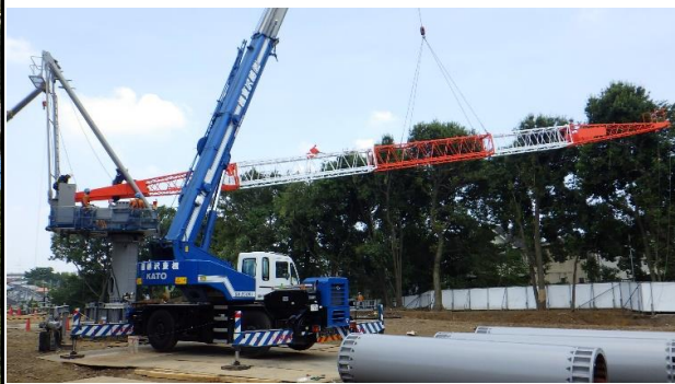
東棟タワークレーン設置工事状況
