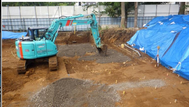
西棟砕石敷き状況
