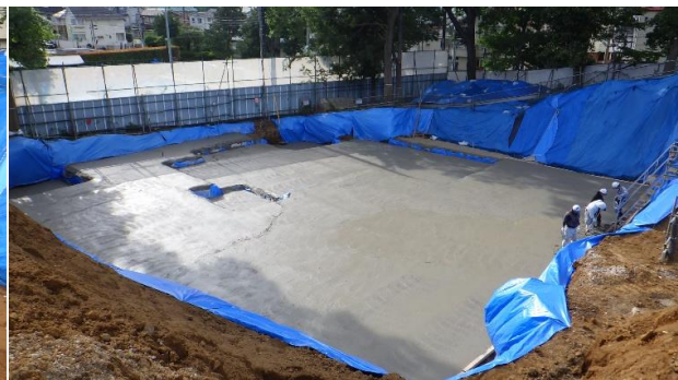
西棟レベルCON打設状況
