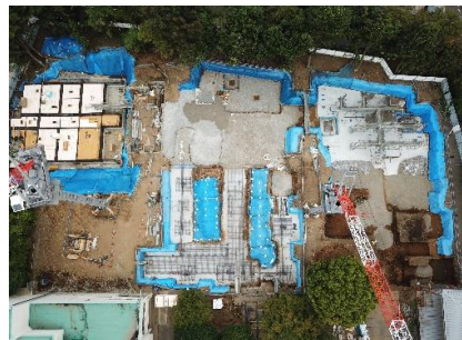
新校舎全体の基礎工事状況
