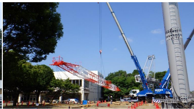
西棟タワークレーン設置工事状況
