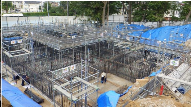
西棟地足場組立状況
