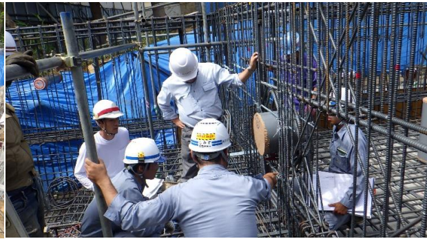
西棟基礎配筋設計監理者検査状況
