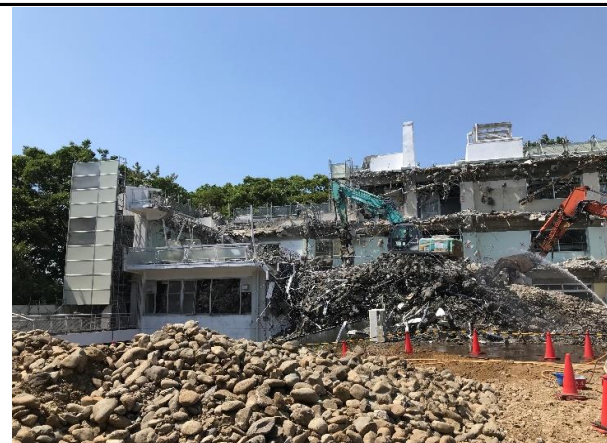
北棟西側外壁躯体解体状況①(全景)
