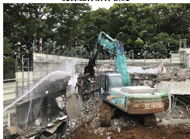
北棟西側外壁躯体解体状況②(近景)
