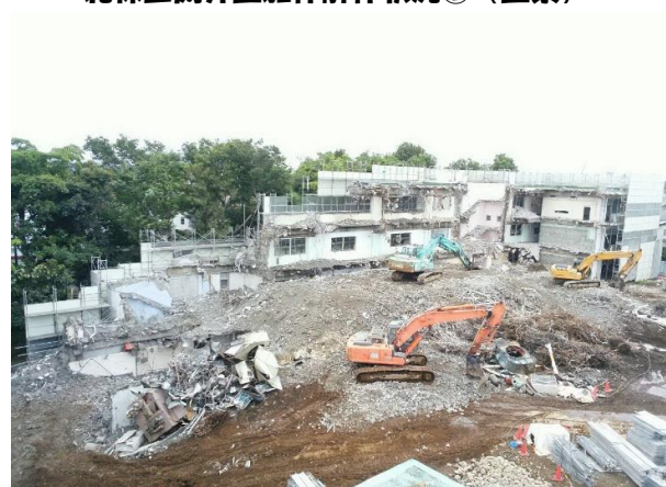
北棟西側外壁躯体解体状況③(全景)
