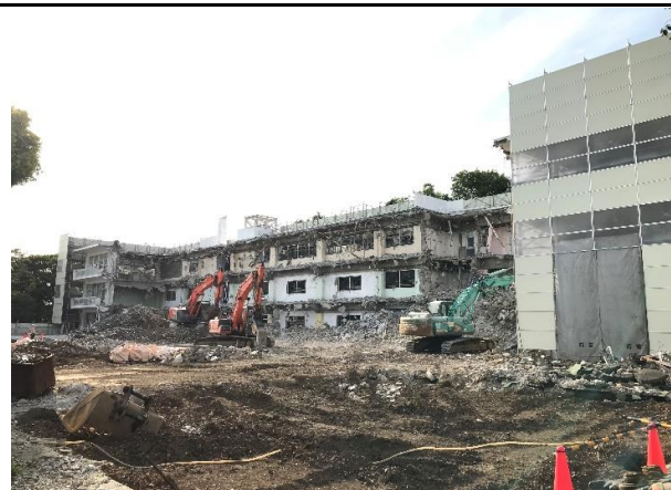
北棟躯体解体状況
