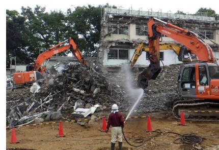
解体中の散水状況
